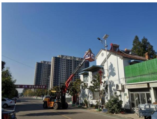
修缮村内房屋外墙立面
